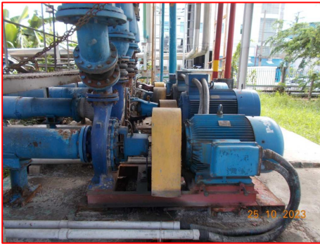
ภาพที่ 2.2-27 อุปกรณ์ครอบเครื่องจักร ที่มีการหมุน
