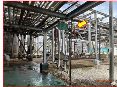
ภาพที่ 2.2-21 อ่างล้างตาและฝักบัวฉุกเฉิน
