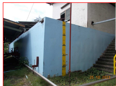
ภาพที่ 2.2-38 บ่อน้ำสำรองดับเพลิง
